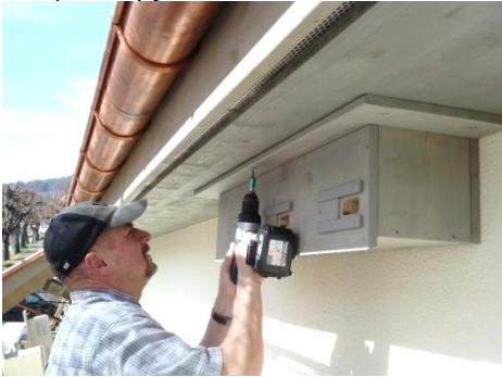
Bucherhaus Blauen, die nagelneuen Spyrenkästen werden montiert
